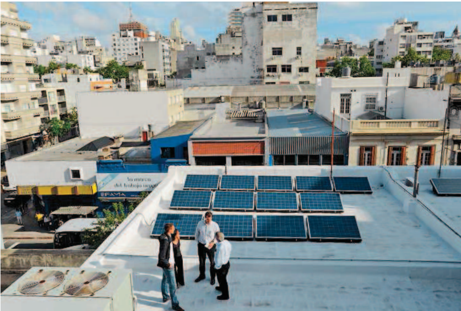
Auch die Photovoltaik soll im uruguayischen Energiemarkt eine Rolle spielen.
