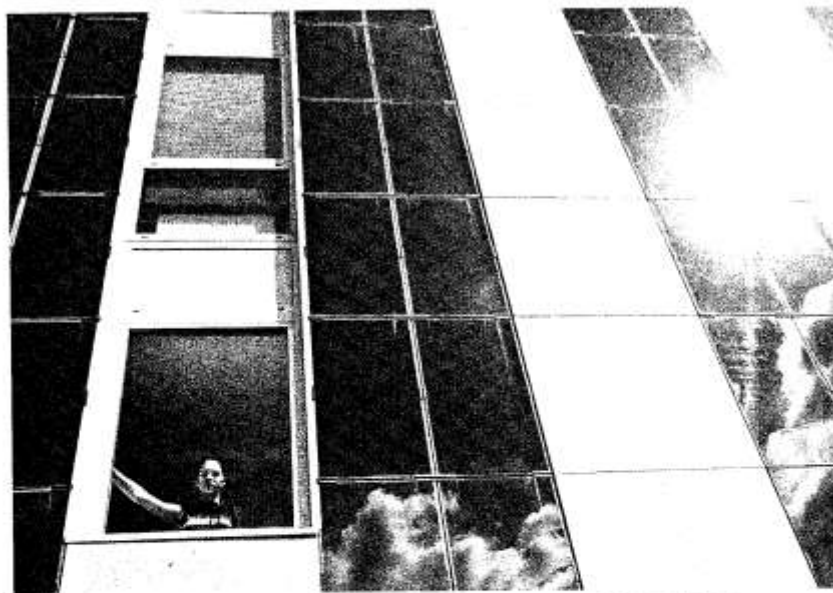
Schaufenster: Im Verwaltungsgebäude von Antec wurden Cadmium-Tellurid-Module aus eigener Fertigung in die Fassade integriert. Das Gebäude selbst gehört der landeseigenen LEG, die bemüht sich um einen Erhalt der Arbeitsplätze.
