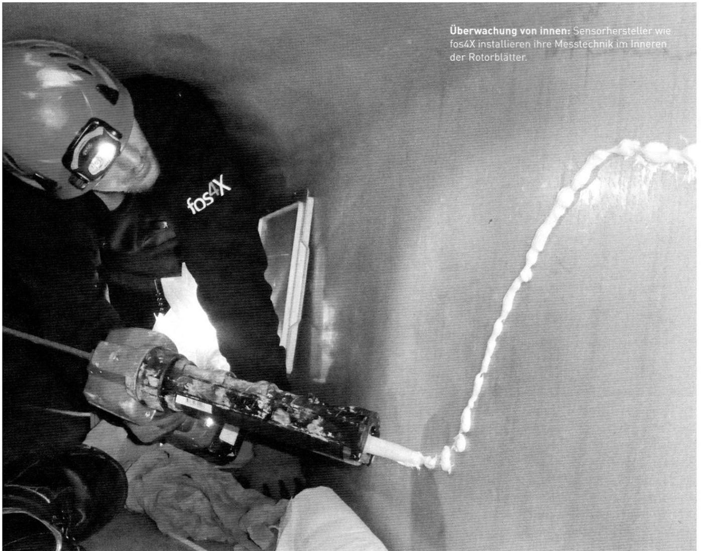
**Überwachung von innen:** Sensorhersteller wie fos4X installieren ihre Messtechnik im Inneren der Rotorblätter.
