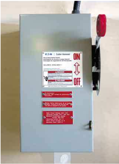
Notaus: Bei Netzausfall kann das System über eine externe Freischaltstelle vom Netz getrennt werden.
