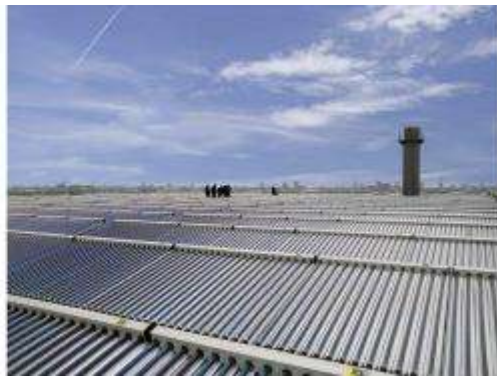
Das fertig installierte Kollektorfeld Bild: Ritter XL Solar
