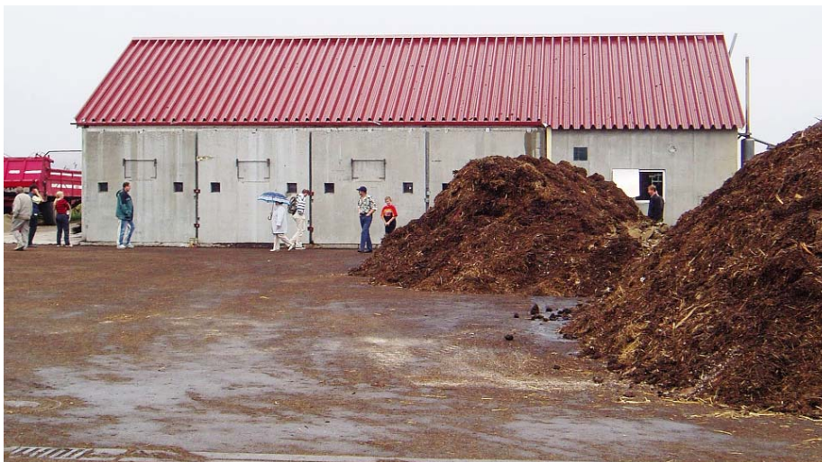
In garagenartigen Boxen aus Beton geschieht die Trockenfermentation auf dem Hof Braun-Keller in Leibertingen.
